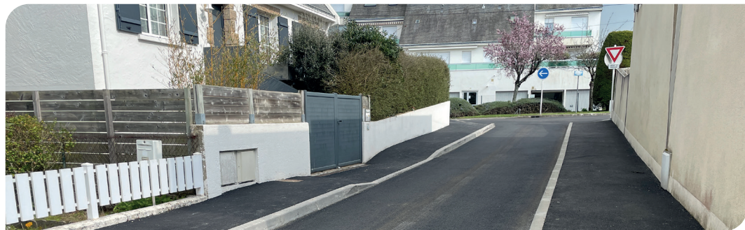
La rue Lebon : une des premières rues concernées par le programme de voirie 2025
